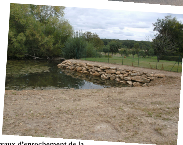
Travaux d'enrochement de la mare de la Tuilerie
