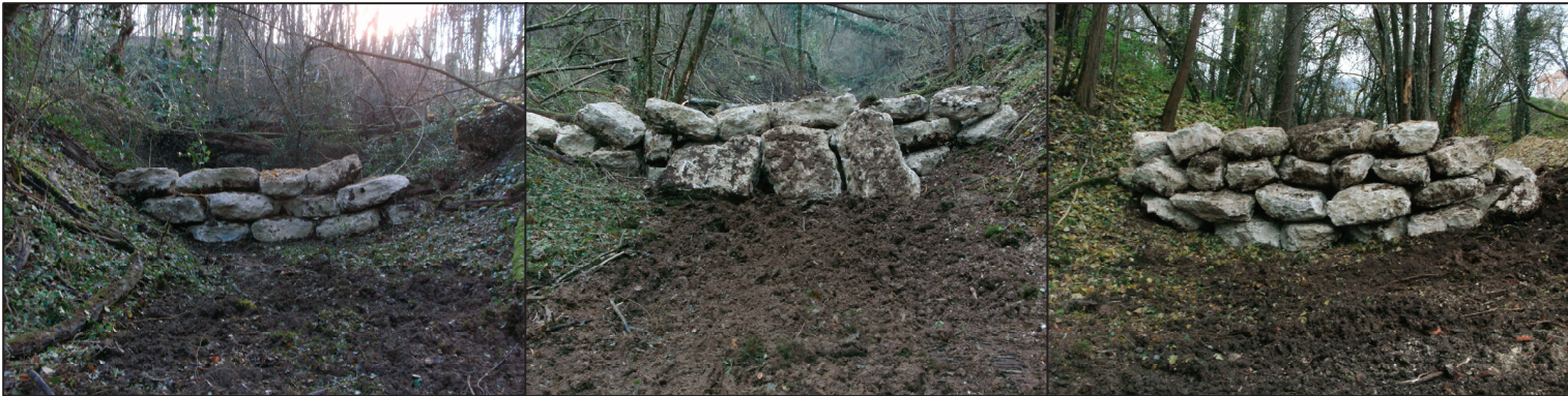
Retenue pour ralentir l'écoulement d'eau dans la ravine
