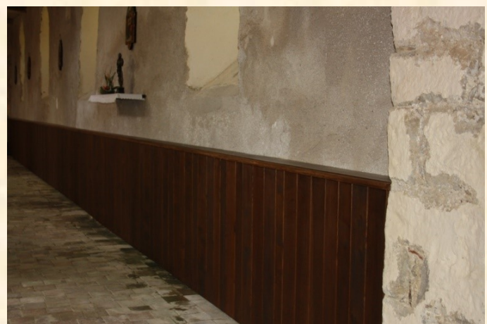
Habillage du mur
