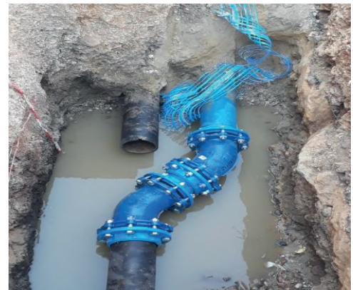
Le raccordement au nouveau réseau
