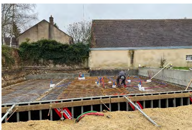
Fondations et ferrailage de la dalle de la classe
