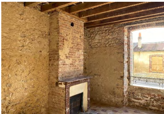
Préparation des murs à l'intérieur du bâtiment
