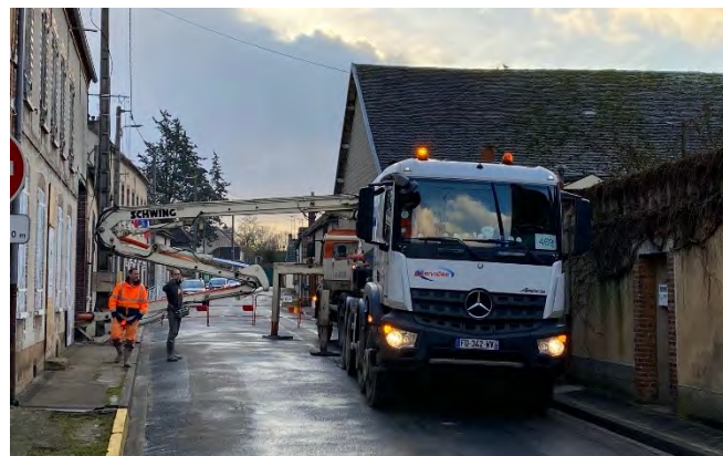
Mise en place pour le coulage de la dalle
