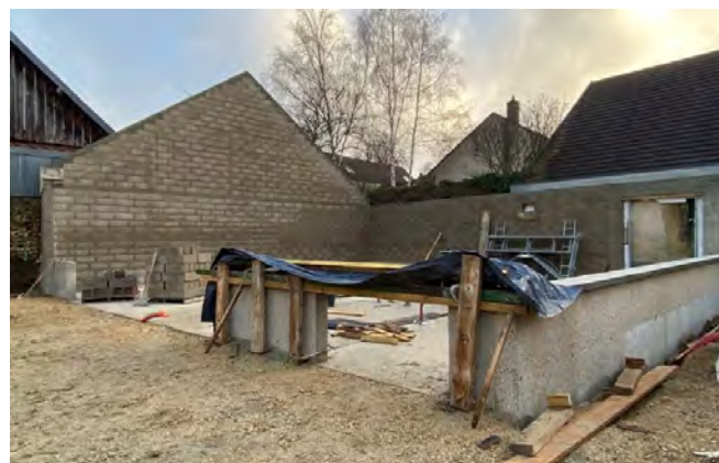
Les murs et le pignon sont montés et sont en attente de la charpente pour début février
