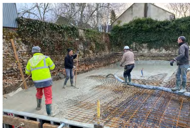
Coulage de la dalle de la salle de classe
