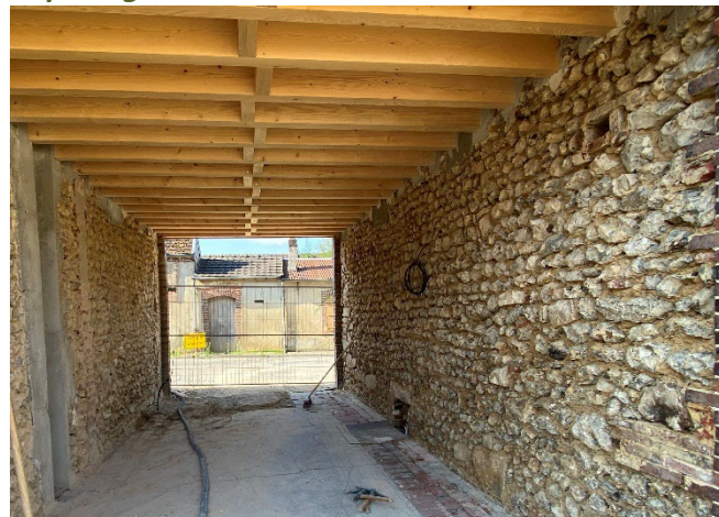
Pose du plancher au dessus du porche ci-dessus Piquetage des murs avant ravalement ci-dessous
