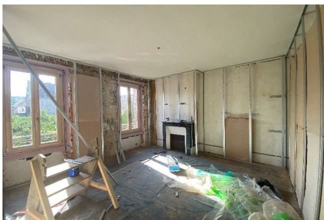
Pose des rails pour le doublage des cloisons
