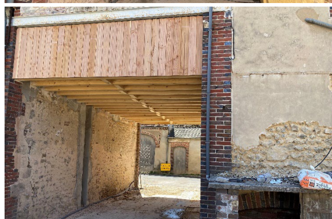
Pose du plancher au dessus du porche ci-dessus Piquetage des murs avant ravalement ci-dessous
