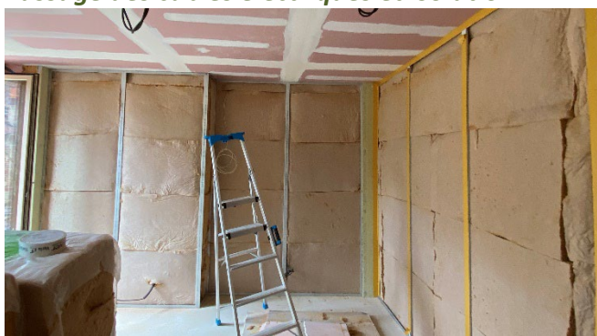
Passage des câbles électriques et isolation
