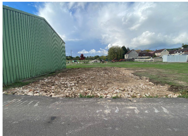
Les matériaux de la démolition ont servi au remblai du futur parking à côté du terrain de sports et du parc matériel à côté du hangar
