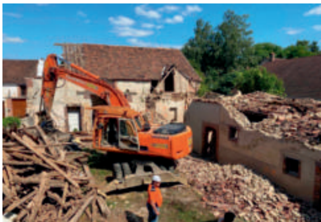
Démolition de la longère à droite
