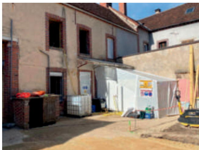
Dans le même temps, désamiantage et déplombage dans le bâtiment à réhabiliter
