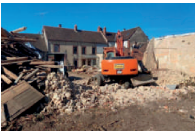
Vue depuis les granges démolies
