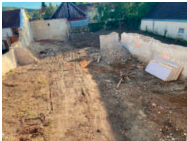
Vue de l'espace libéré après démolition
