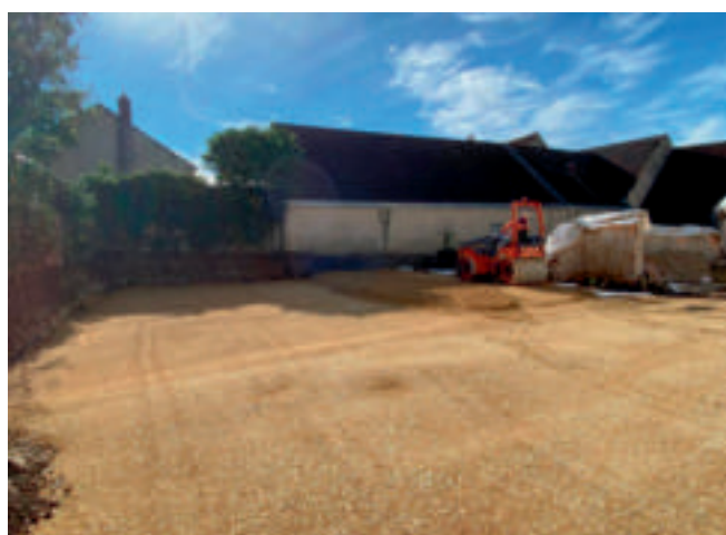
Les remblais sont commencés
