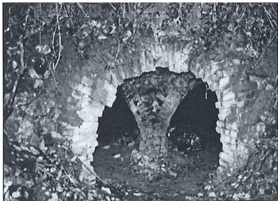
L'entrée du four de Vaucréchot
